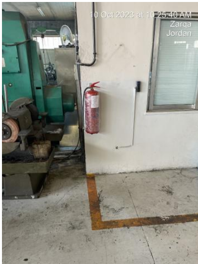
Fire extinguisher (2).jpeg
